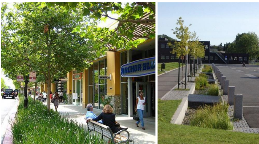
Exemples de noues paysagères dans un centre-ville
