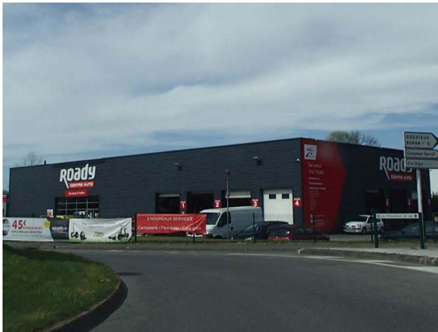
La surface des enseignes est inférieure à 15 % de la surface de la façade
