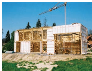
Chantier d'une maison à ossature bois
