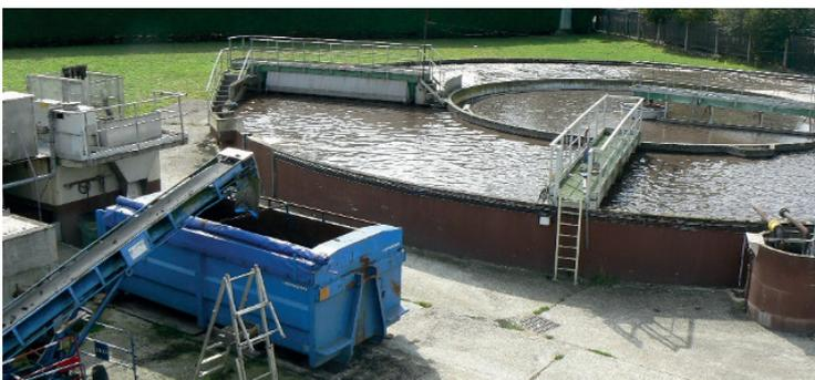
Station d'épuration de Lamorlaye. Bassin d'aération (couronne extérieure circulaire) et bassin de clarification (cerle au milieu). Conteneur bleu : réception des boues.
