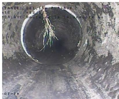
Racines et fissure circulaire (route de la Seigneurie et rue de la Seigneurie) extraites d'inspection du réseau par caméra.
