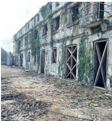
Les travaux de construction de la future médiathèque avancent. La phase de sécurisation du bâtiment de l'Orangerie, élément central du projet, vient de s'achever. Cette étape cruciale a permis de stabiliser la structure existante et de garantir des conditions de travail optimales pour les prochaines interventions.
